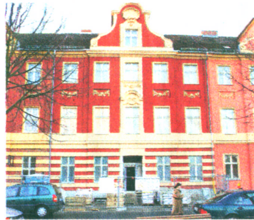
In das sanierte Haus Am Bassin 3, erbaut 1783, ziehen neue Mieter ein. Foto: A. Klaer
